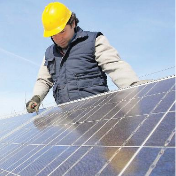
FOTovoltaico Tra i lavori previsti negli edifici anche l'installazione di pannelli solari per la produzione di energia
