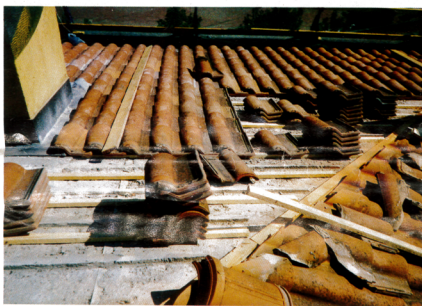
Ricorsa generale del manto in tegole, posa di sottocoolmo ventilato
