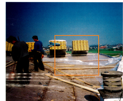
Sostituzione totale del manto di copertura, impermeabilizzazione della gronda e sostituzione della lattoniera
