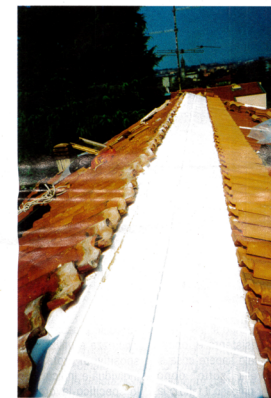
Posa di isolate e di nuovo manto di tegole portoghesi
