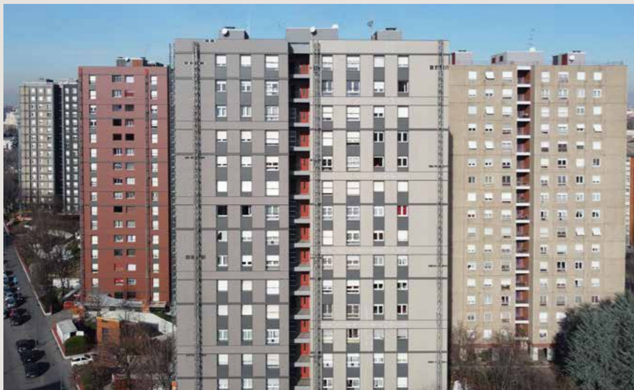
→ Vista del cappotto prima dell'installazione della facciata ventilata (a sinistra)
