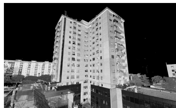
↑ Il fabbricato rilevato
