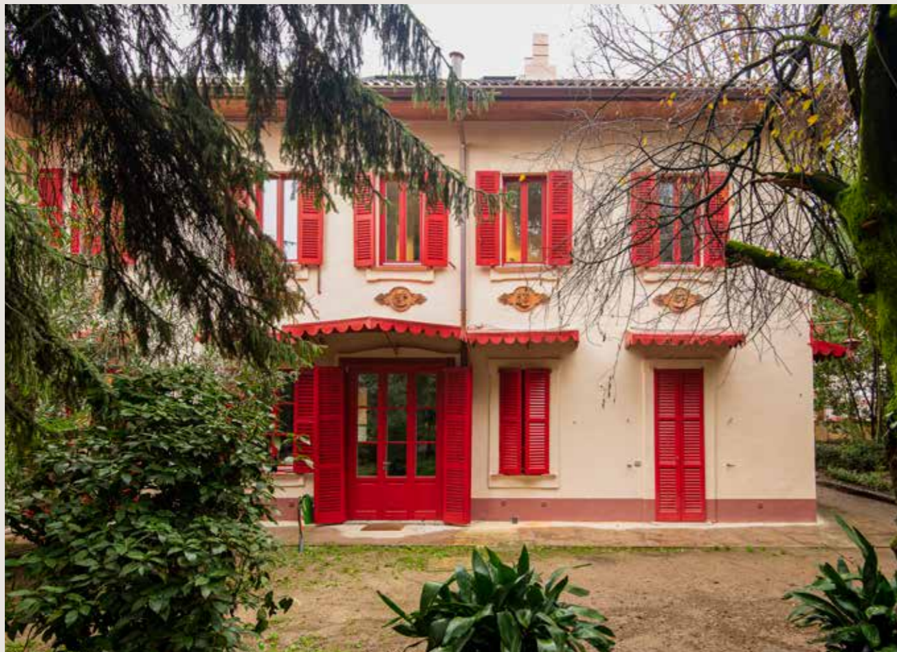
↓ Vue de la façade après la fin des travaux
